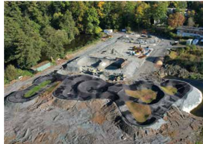
Hier entsteht die neue Freizeitsportanlage am Eisteich
