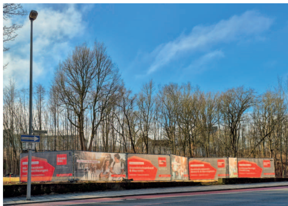
Hier in der Schützenstraße baut das Studentenwerk Oberfranken ein neues Wohnheim mit bis zu 130 Apartments.
